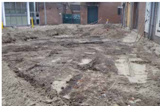
Fig. 11 Weggraven van bestrating en 30cm zandpakket
